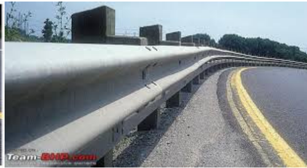
Fig. 20. Use of Steel Barrier.
