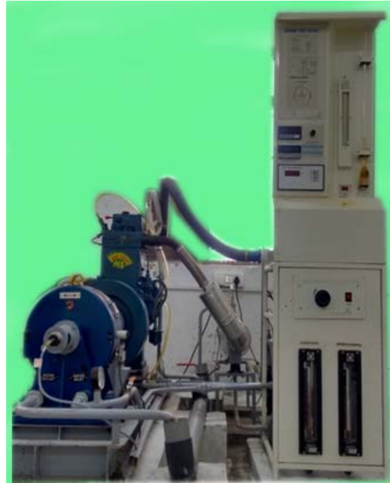
Fig. 1. Engine Test Rig.
